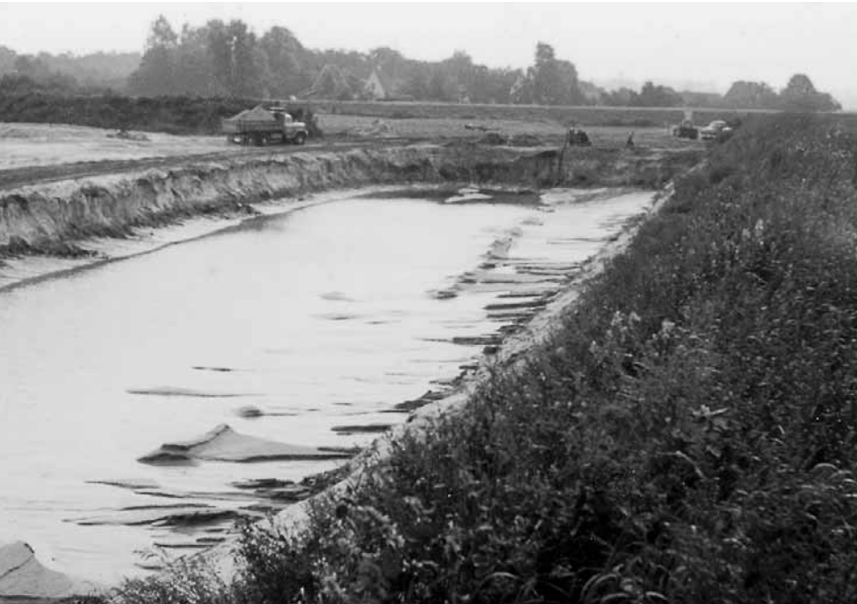
De put van Blauwendraad in wording. Deze natte ontgroning was gelegen ten noorden van de Nieuwe Weteringsegeweg, dichtbij het viaduct over de spoorlijn en het tracé van de rijksweg. Aan het begin van de betreffende percelen staan nu twee borden van Bomencentrum Nederland B.V.
